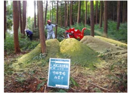
（使用する資機材の様子）
